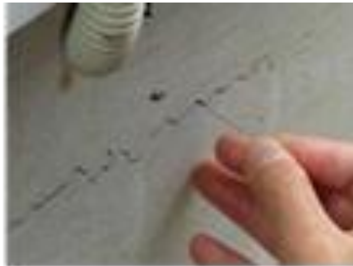
ピアノ線（ひび割れ深さの計測）
