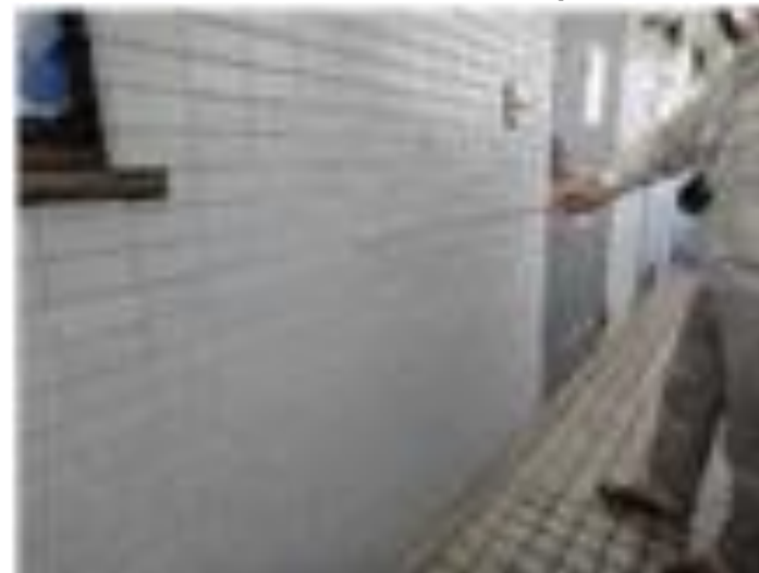
打診棒（タイルの浮きの調査）
