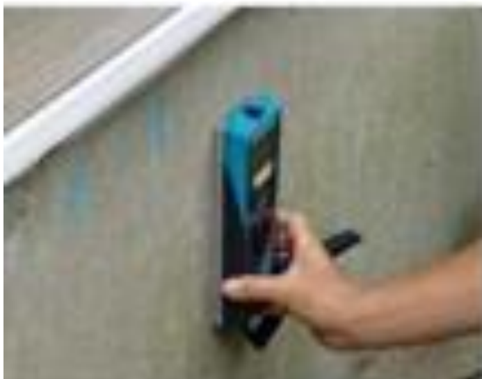
鉄筋探査機（基礎配筋の調査）
