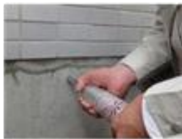
リバウンドハンマー（コンクリート圧縮強度の測定）
