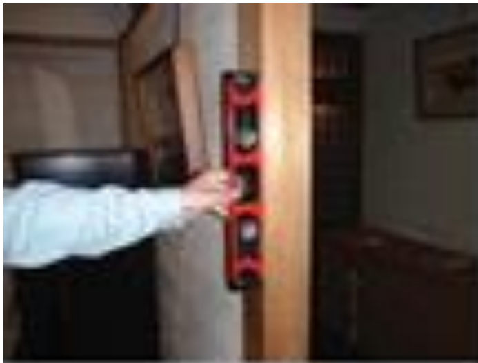
水平器（柱の傾きの計測）
